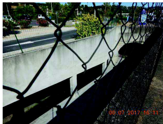
Ouvrage galerie sous le Riuo Blanquet
